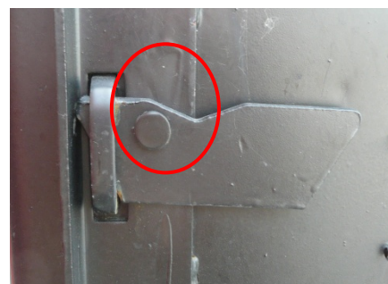
32.10.5 Sulaužytas užrakto mechanizmas, neremontuojama
