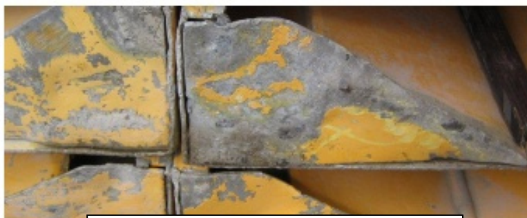
24.16 Deformuota dengiamoji plokštelė
