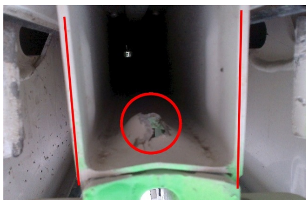
21.17: Skylė sijos viduje (profilis nedeformuotas)
