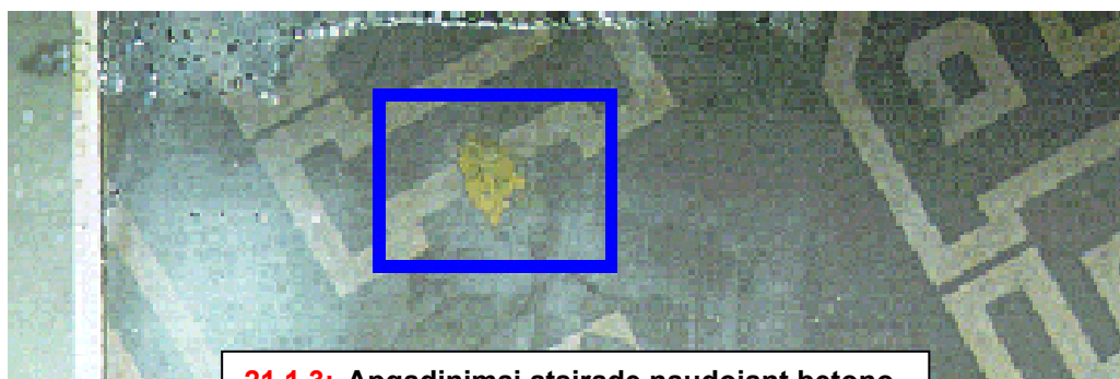
21.1.3: Apgadinimai atsiradę naudojant betono vibratorių, gilesni nei 1 mm
