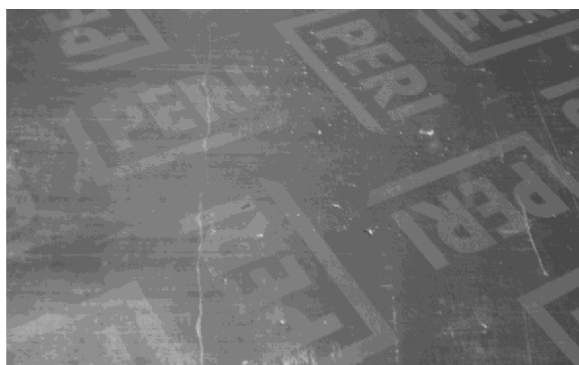
21.1.1: Smulkūs pažeidimai, remontuoti nereikia.
